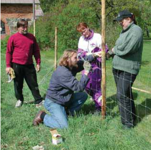
Fårnät som stängselmaterial håller länge. Stolparna bör vara stadiga och tillverkade av hållbart material.
